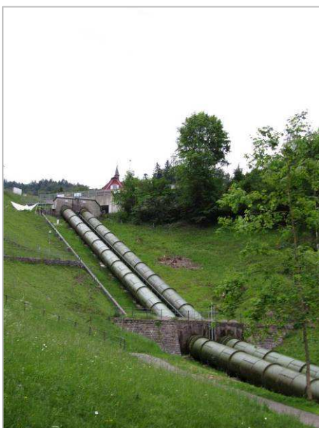
Steil gehen die Wasserleitungen vom Stausee in das Kraftwerk
