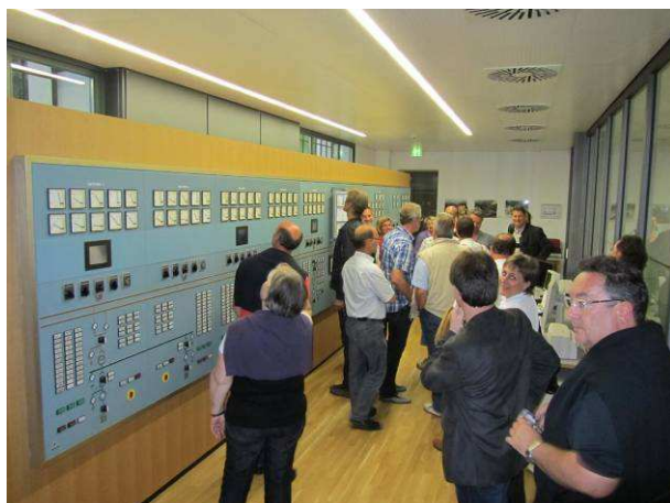
Die Steuerzentrale des Kraftwerks
